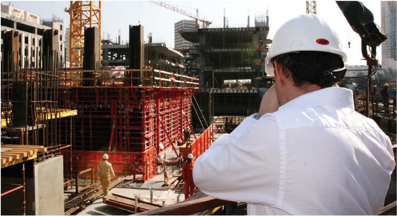
مشروع الحمراء / موقع البناء
